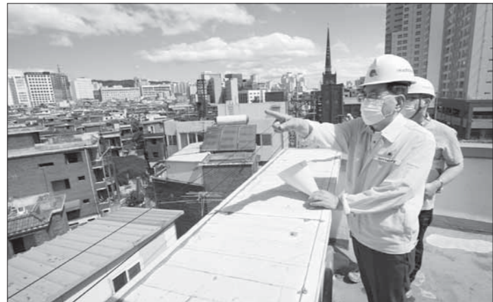
유덕열 동대문구청장, 철거 현장 안전점검 나서
