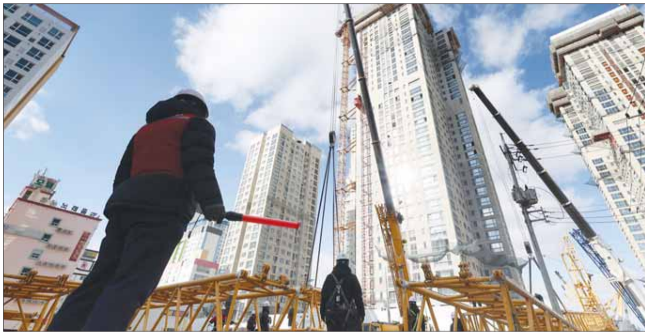
타워크레인 해체 준비작업
